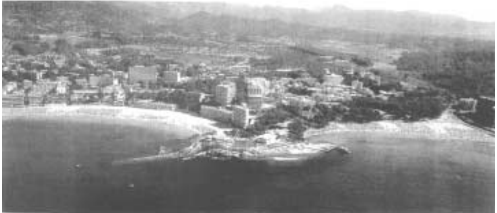
Todos los proyectos están relacionados con la mejora del litoral y el fomento de energías renovables
